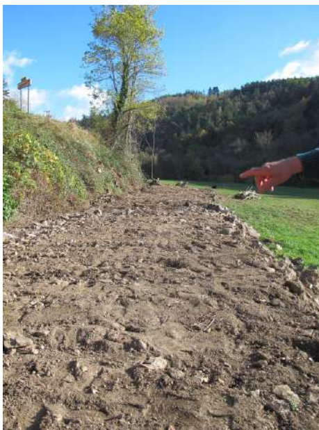
Photo 3 : État du béal aval le 30 octobre 2017 après son arasement.
