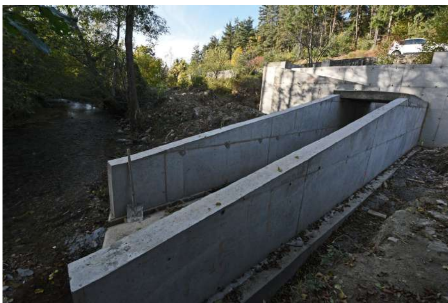
Photo 2 : Déversoir donnant sur la Desges à gauche et dégrilleur le 13 octobre 2017.
