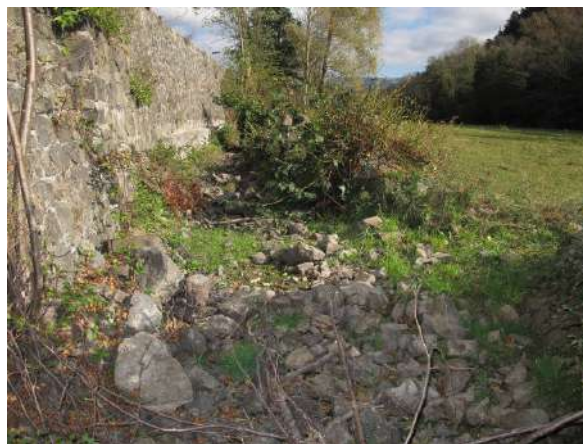
Photo 5 : État actuel – le 28 octobre 2017 – du béal amont.
