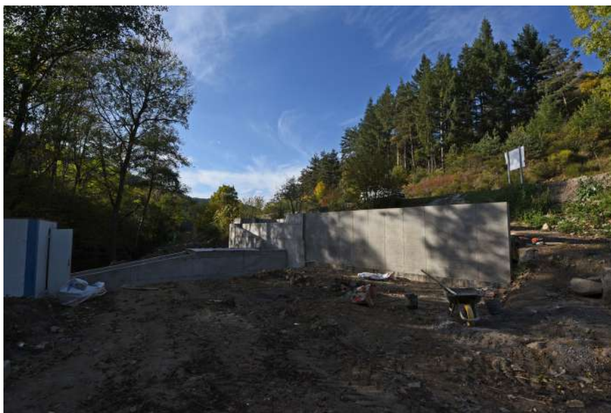
Photo 1 : Déversoir, dégrilleur et début du béal amont rehaussé le 13 octobre 2017. Le pont sur l'ancien béal est à droite de la photo et immédiatement à droite du nouveau mur du béal rehaussé.
