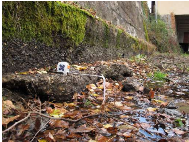
Photo 13 : Creusement naturel du béal de 10 à 16 cm hors sol cimenté à proximité des parcelles AE 241 et 242.
