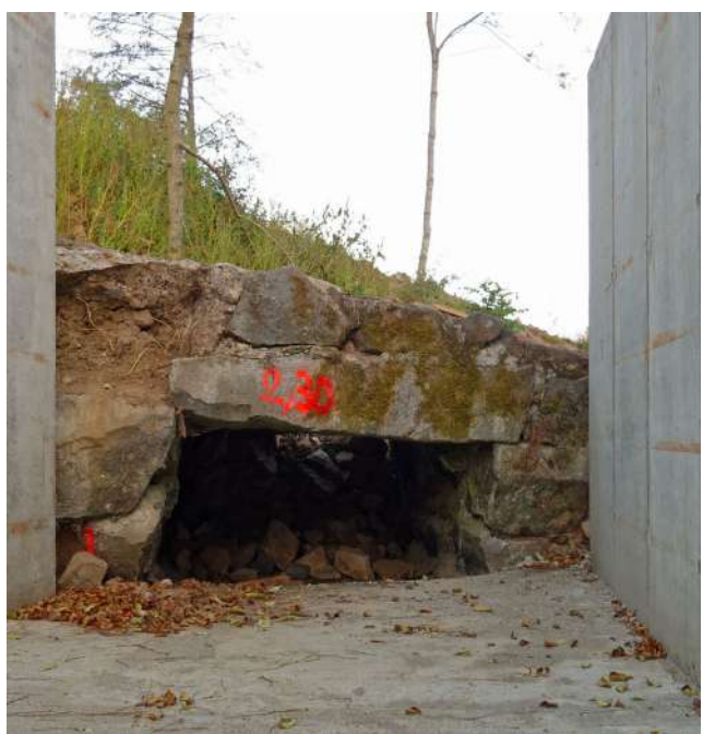
Photo 12 : Pont juste en amont du dégrilleur, à 488 m de la vanne d'entrée, vu de l'aval le 26 octobre 2017.
